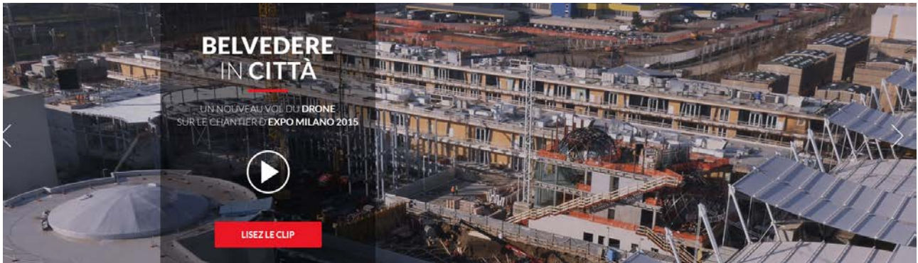
Chantier de l'Exposition Universelle Milan 2015 - www.expo2015.org
